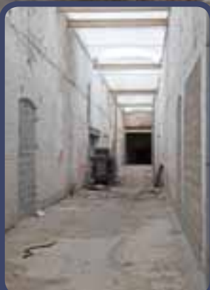
Actival 2, rue de Lille entre Centre et Blanc-Four, une réserve foncière idéalement située dans le cadre d'une reconquête urbaine.
